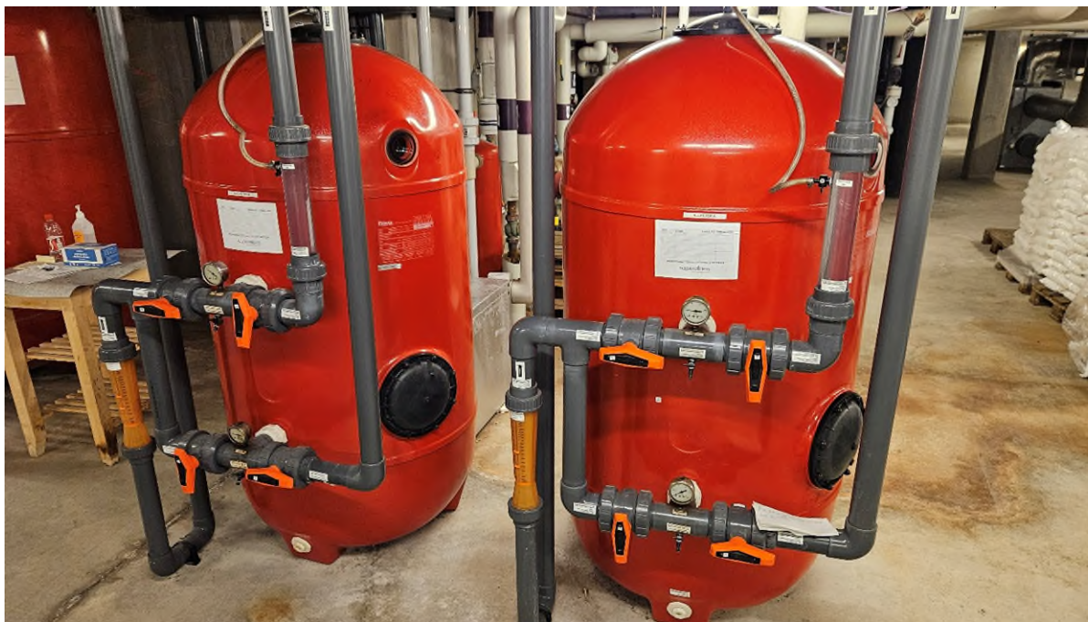
De 2 kulfiltre til multibassinet.
