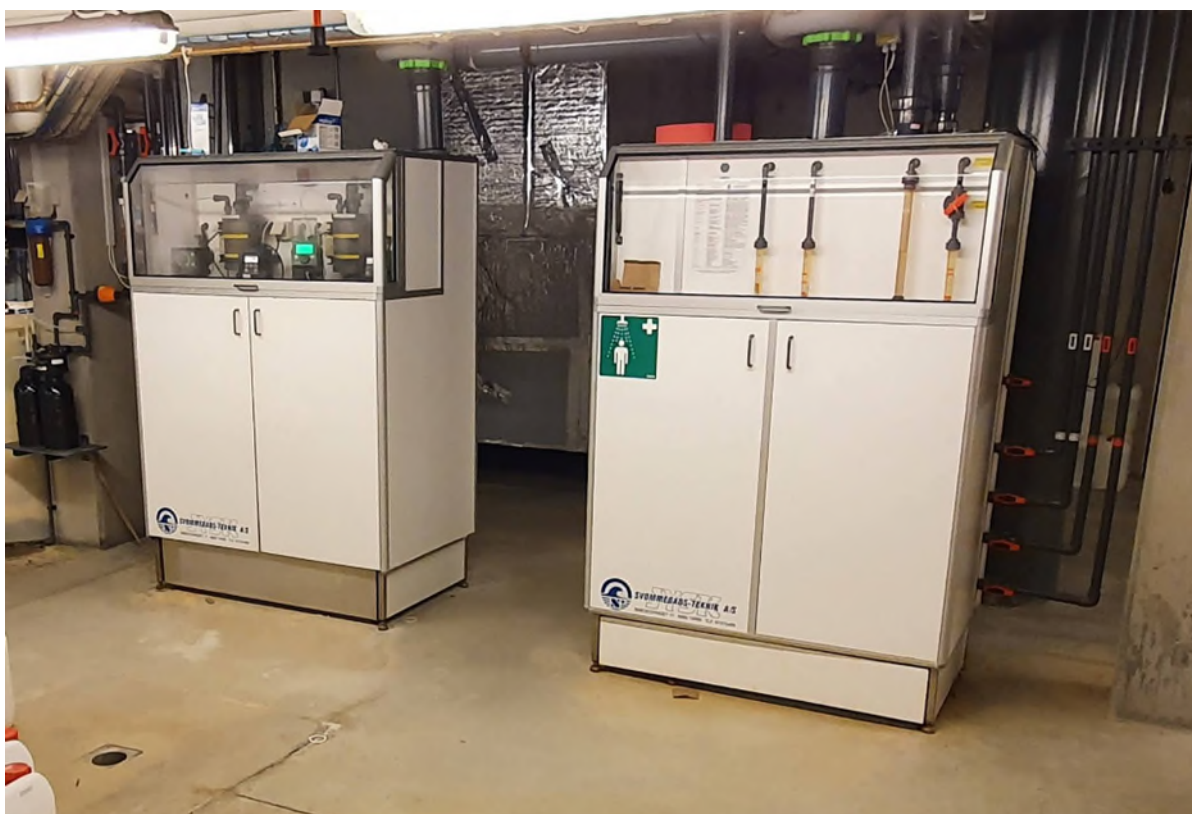
Kemikalieskabe for syre/flokning til venstre og klor til højre.
