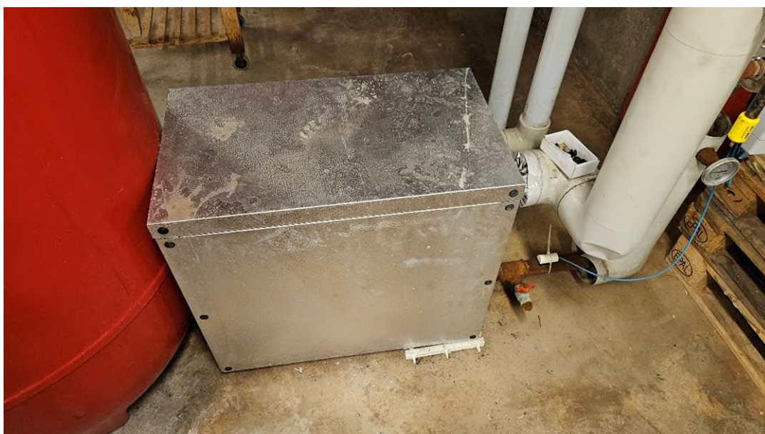
Pladevarmeveksler til Multibassinet i isoleringskappe.
