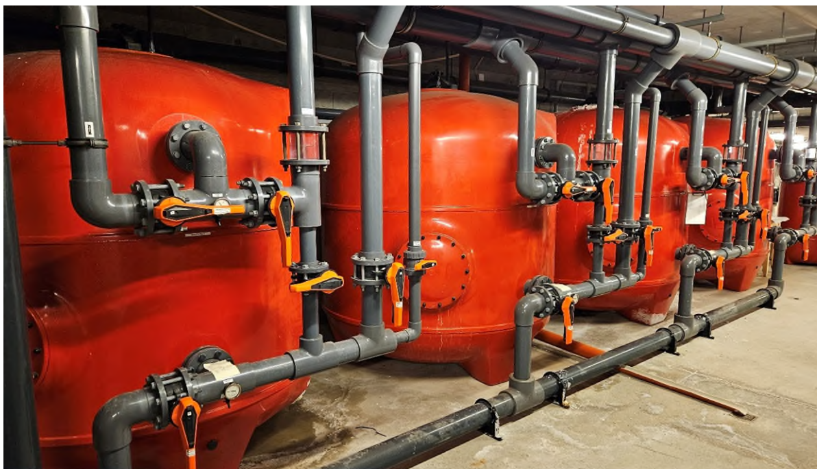
Tryksandfiltre for multibassinet.
