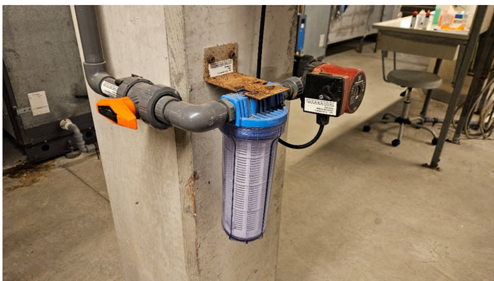
Fødepumpe og forfilter til målevandsautomatikken til Multibassinet.
