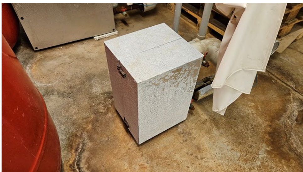
Pladevarmeveksler til Multibassinet i isoleringskappe.
