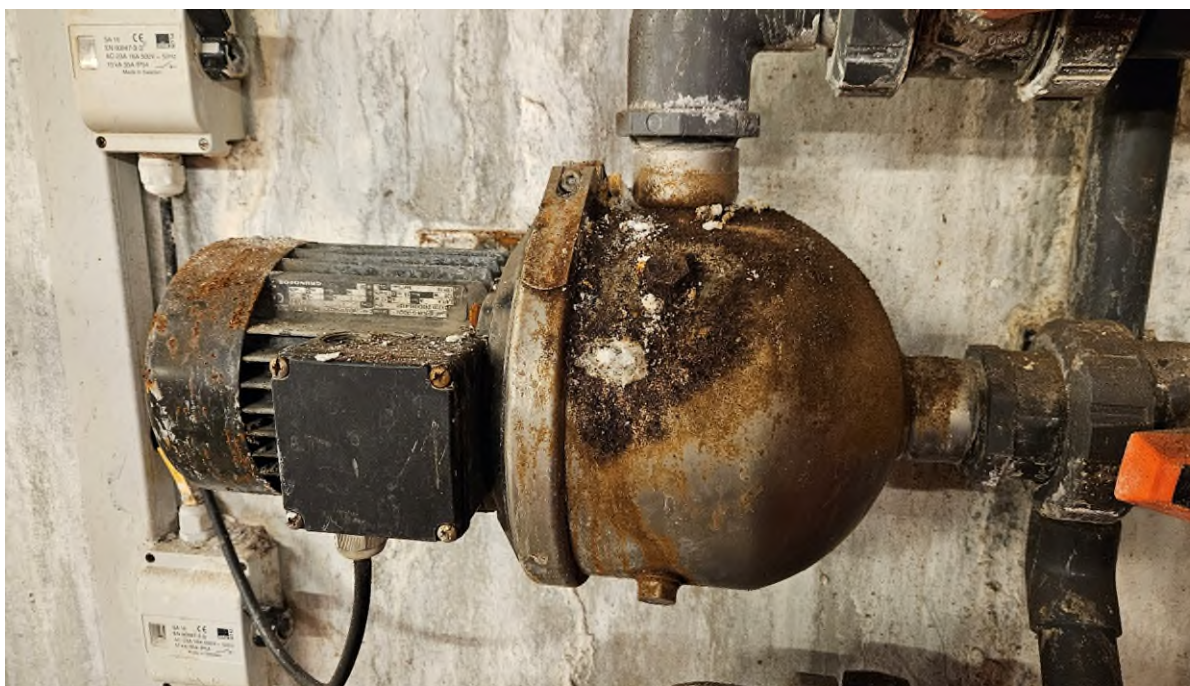
Delstrømpumpe til kemikaliedoseringen.
