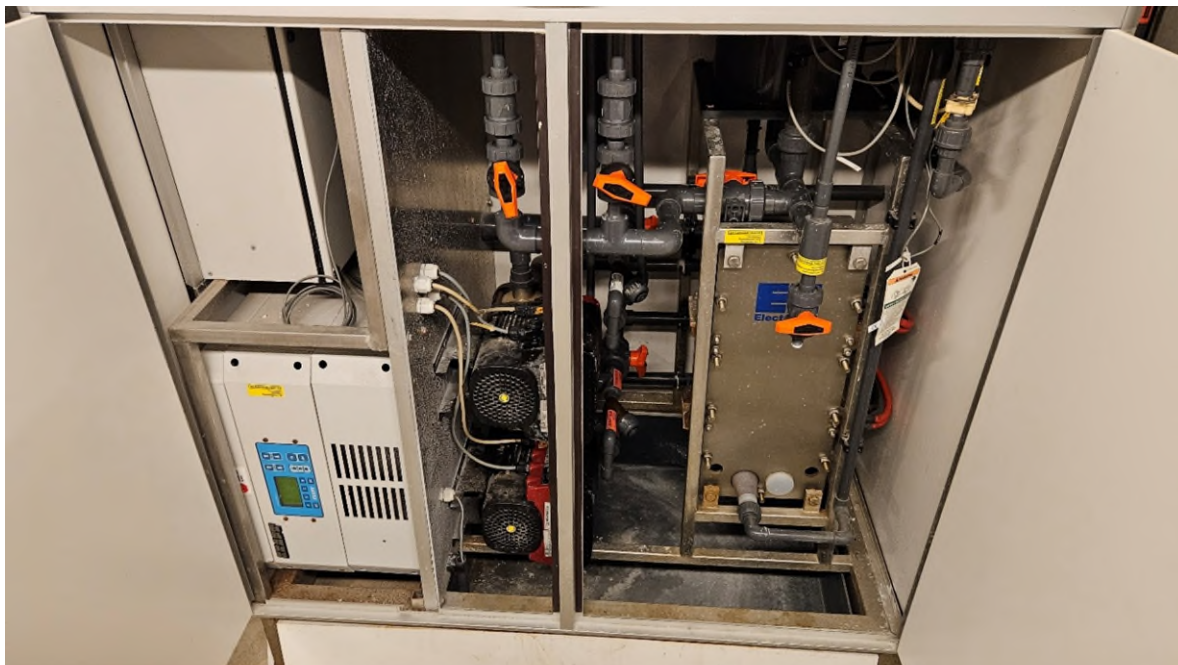
Electrocell anlæg til egen produktion af klor.
